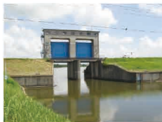
↑①印旛水門(国土交通省管理) 利根川と長門川の接点に設けられた施設で、利根川の洪水時にゲートを閉めます。MAP-1 L-1
