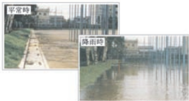
学校校庭を利用した雨水貯留施設 †
