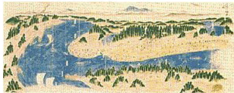
赤堀川開削の様子
